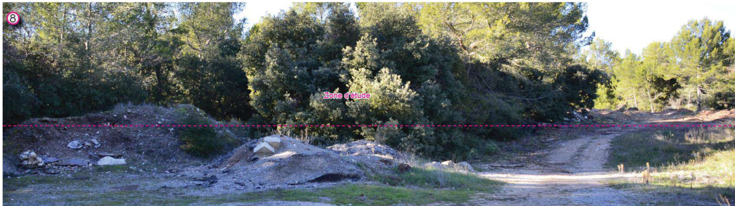
Dépot de gravats en partie revégétalisés.
